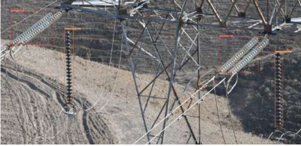
Şekil 5 Farklı türdeki izolatörlerin tespiti
