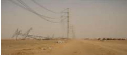
Şekil 1. ABD'de Fırtına Sonrası Yıkılan Enerji Nakil Hattı
