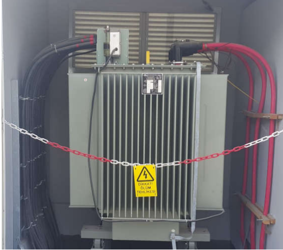
Şekil 2. Yazılım testleri için kullanılan transformatör
