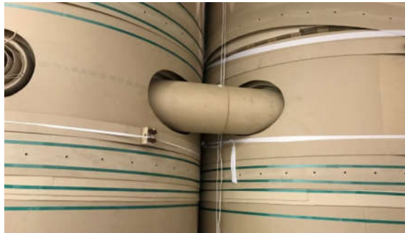
Şekil 17 Trafo içerisinde ki Montajın tamamlanması
